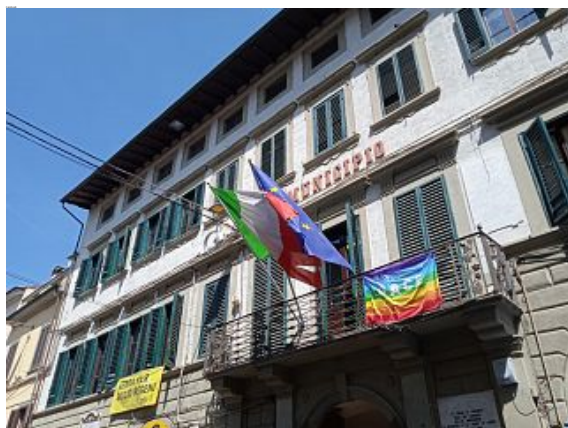
Palazzo Stefanelli a Pontedera
